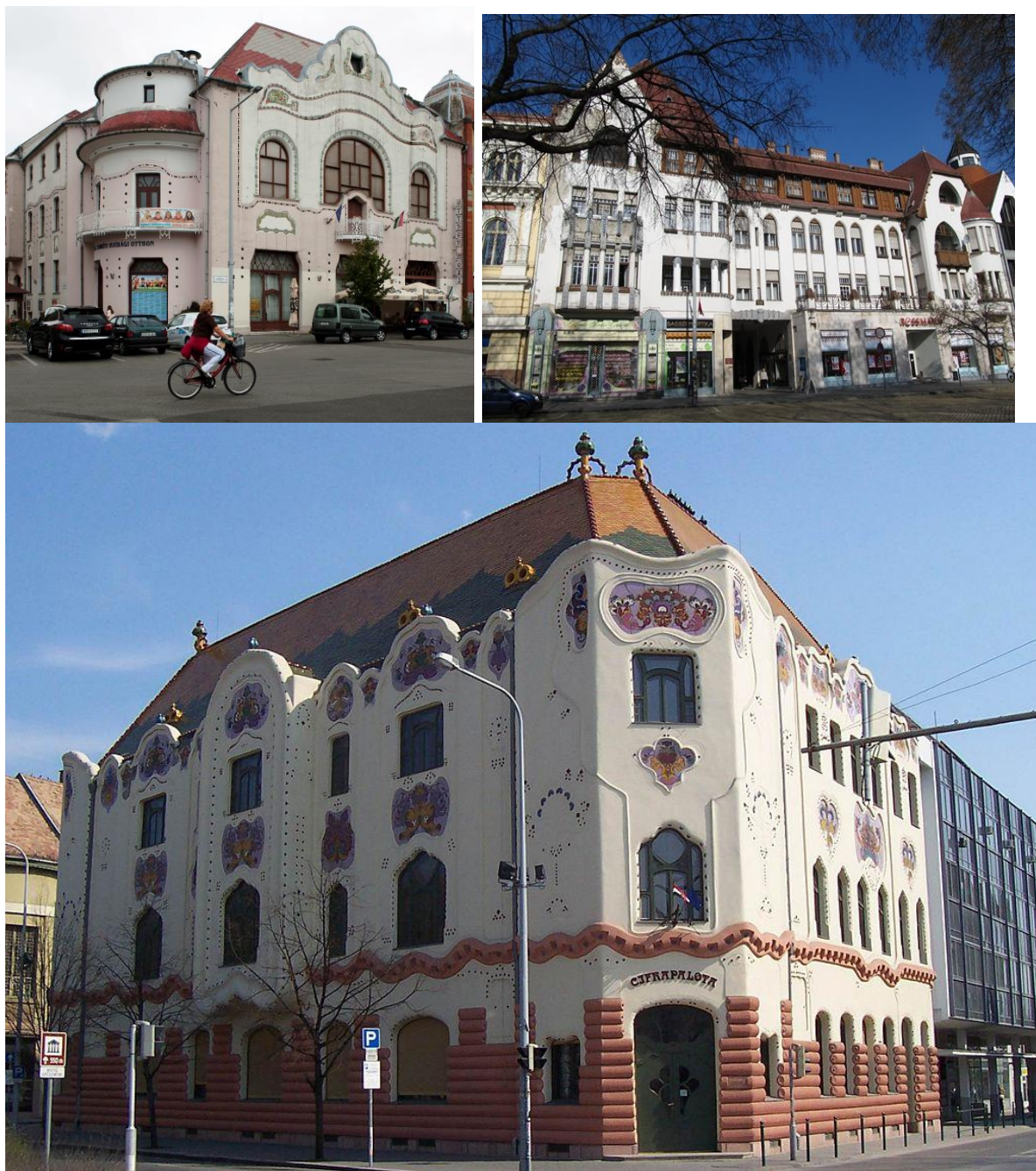
9. ábra: A felújításra váró főtéri műemléki épületek
