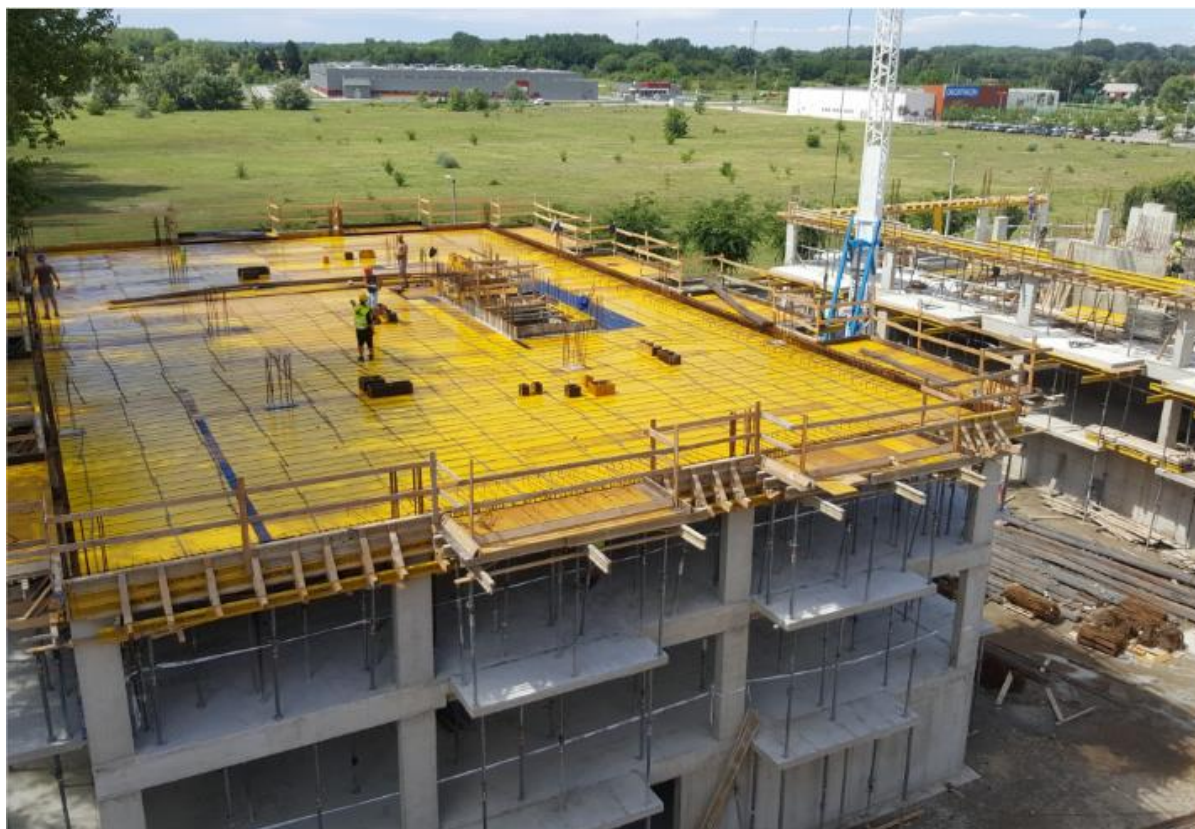
71. ábra: Boróka lakópark építése
