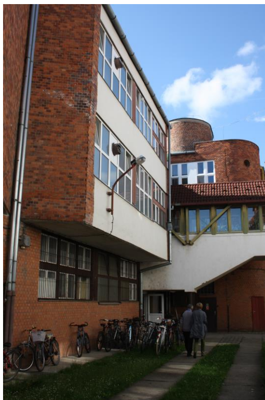
36. ábra: A Kecskeméti Szakképzési Centrum Kollégiumának felújításra váró épülete
